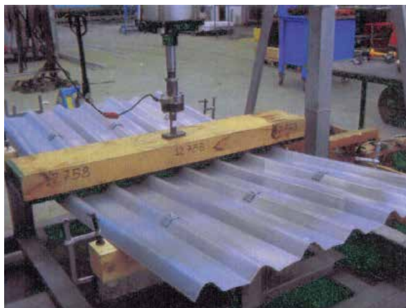
Fig. 1 – prova con carico concentrato nella mezzeria della campata
